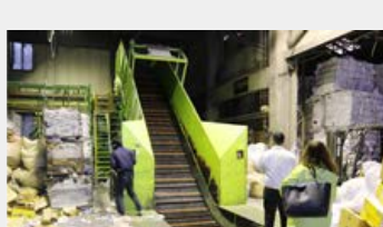
圧縮機ベルトコンベヤー
