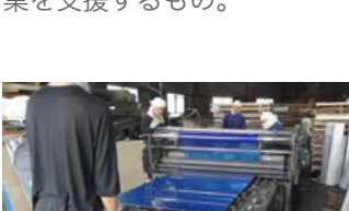
保護テープ貼り付け作業
